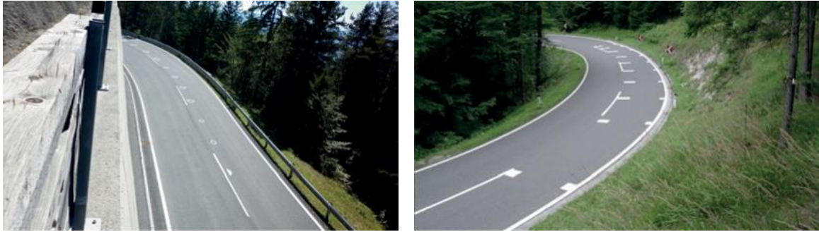
Abbildung 4: Ellipsenmarkierung (links) und Balkenmarkierung (rechts) nach Aufbringung (Winkelbauer, et al., 2017)
